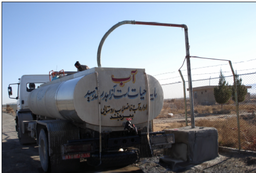
تصویر سکوی آب گیری تانکرهای حمل آب
